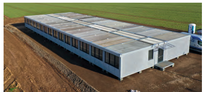
Die neue Unterkunft für Menschen, die in Deutschland vor Krieg und Verfolgung Zuflucht suchen, wurde in den vergangenen Tagen von einer Fachfirma im Zülpicher Industriegebiet aufgebaut. Das aus 36 einzelnen Containern bestehende Gebäude bietet Platz für bis zu 50 Personen. Foto: Stadt Zülpich / Torsten Beulen
